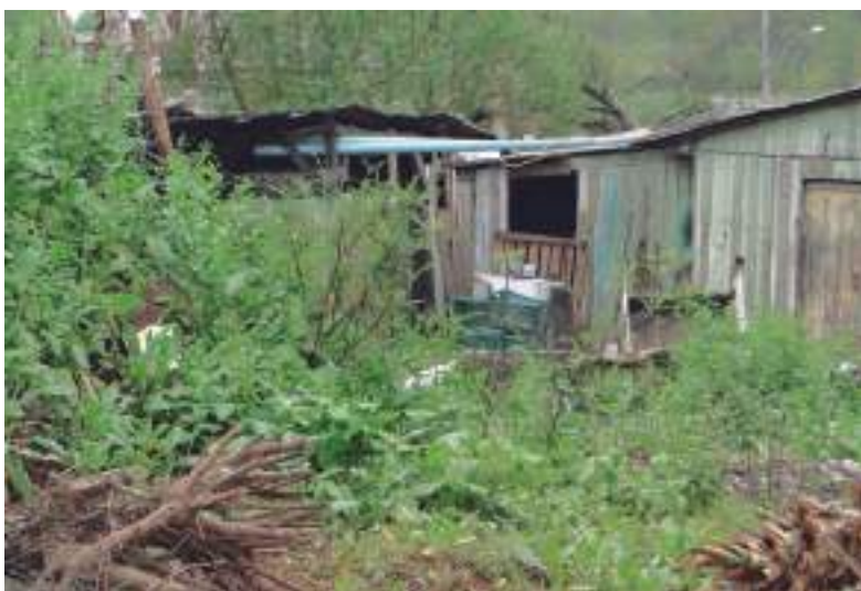
Imagem 13 - Habitação existente considerada precária na avaliação do levantamento. Fonte: PROJETO DE EXTENSÃO ARQUITETURA E COMUNIDADE, 2009.
