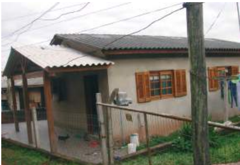
Imagem 6 - Habitação existente considerada em boas condições na avaliação do levantamento. Fonte: PROJETO DE EXTENSÃO ARQUITETURA E COMUNIDADE, 2010.
