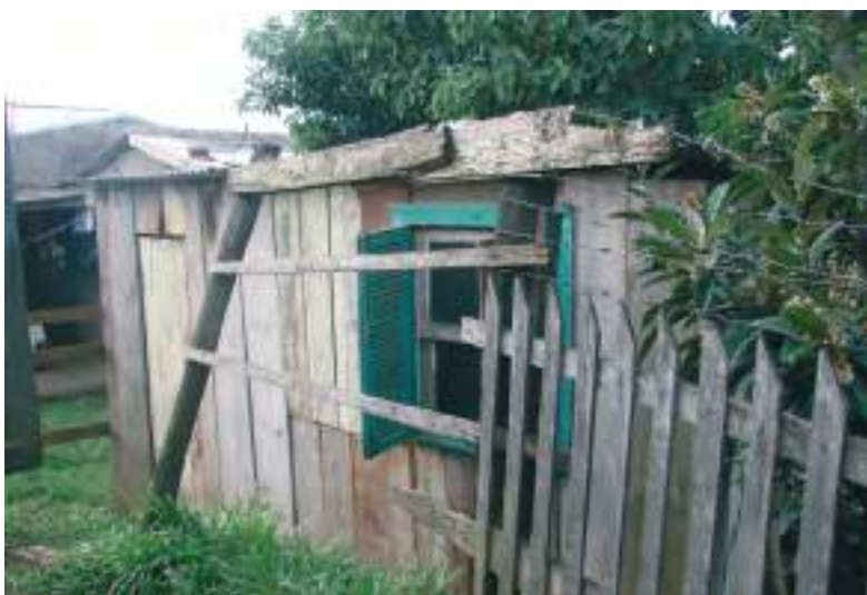
Imagem 8 - Habitação existente considerada precária na avaliação do levantamento. Fonte: PROJETO DE EXTENSÃO ARQUITETURA E COMUNIDADE, 2011.
