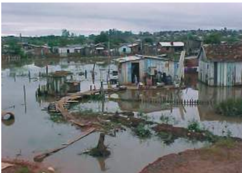
Imagem 6 - Inundação na porção sul da Comunidade Getúlio Vargas. Fonte: Arquivo SEHAB.
