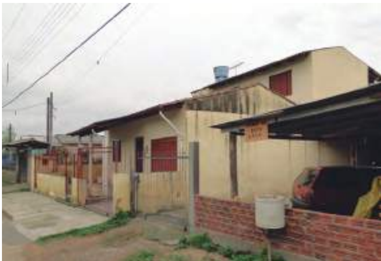
Imagem 11 - Habitação existente considerada em boas condições na avaliação do levantamento. Fonte: PROJETO DE EXTENSÃO ARQUITETURA E COMUNIDADE, 2009.
