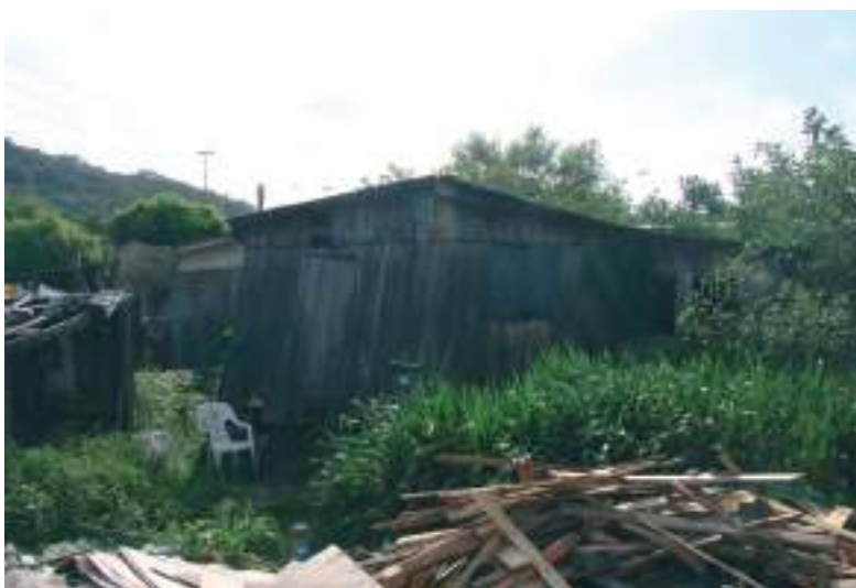
Imagem 8 - Habitação existente considerada precária na avaliação do levantamento. Fonte: PROJETO DE EXTENSÃO ARQUITETURA E COMUNIDADE, 2010.
