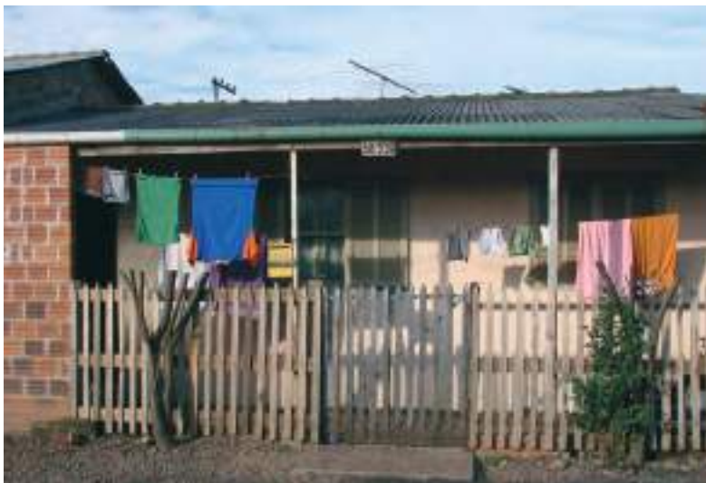
Imagem 7 - Habitação existente considerada em boas condições na avaliação do levantamento. Fonte: PROJETO DE EXTENSÃO ARQUITETURA E COMUNIDADE, 2010.
