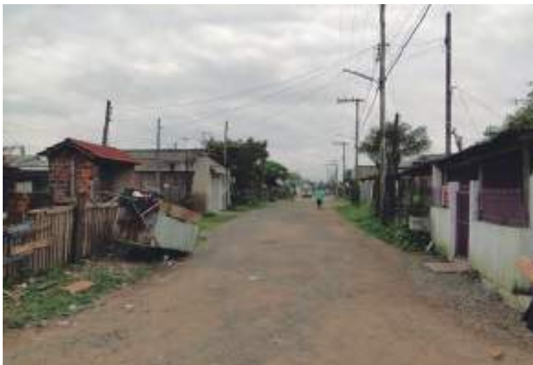
Imagem 7 - Via com camada de brita. Fonte: NEUMANN, 2009.
