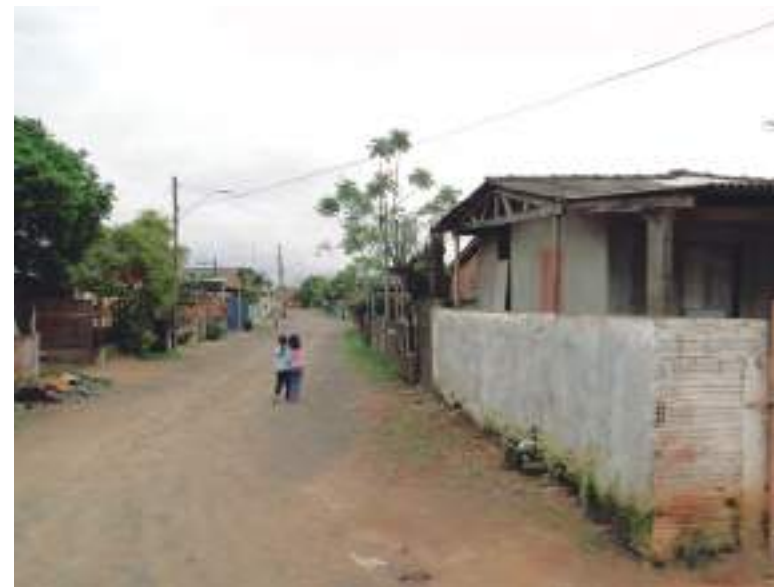
Imagem 15 - Rua a ser urbanizada. Fonte: NEUMANN, 2009.
