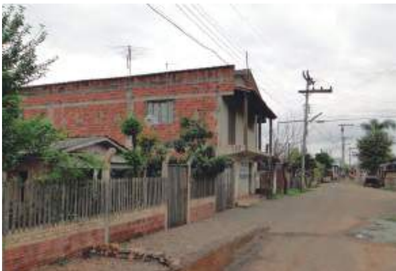
Imagem 12 - Habitação existente considerada em médias condições na avaliação do levantamento. Fonte: PROJETO DE EXTENSÃO ARQUITETURA E COMUNIDADE, 2009.
