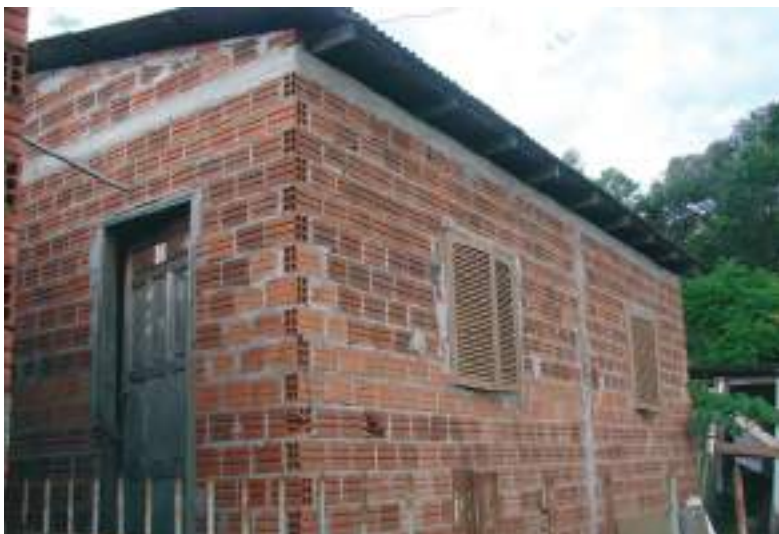
Imagem 7 - Habitação existente considerada em médias condições na avaliação do levantamento. Fonte: PROJETO DE EXTENSÃO ARQUITETURA E COMUNIDADE, 2010.
